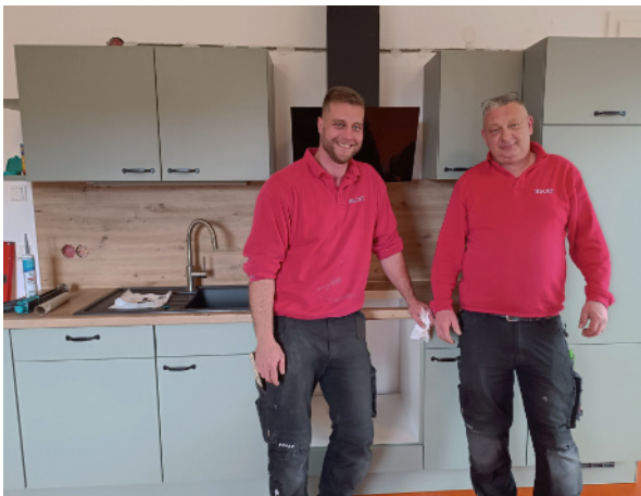
Einbau der neuen Küche im Kinderhaus. Mitarbeiter von Küchen-Hecht
